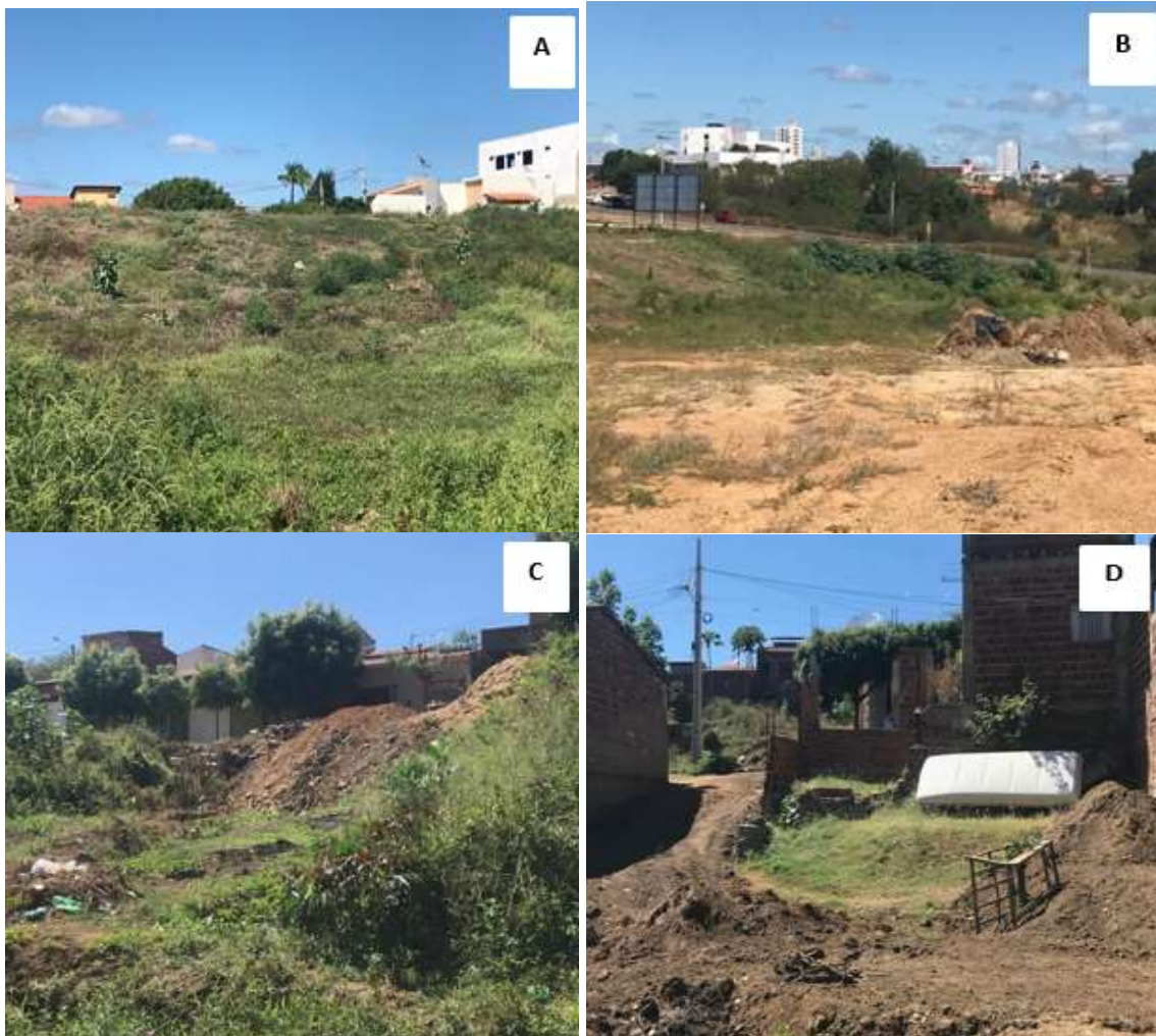
Figura 14 - Identificação de áreas erodidas e com riscos de deslizamento: (A) PB-393, (B) Rua Vinte, (C) Rua Cento e Vinte e Quatro e (D) Rua Rafael Moreira Costa
